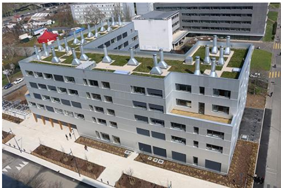
Bâtiment MAX WEBER, Université Paris Ouest Nanterre La Défense (UPOND)
